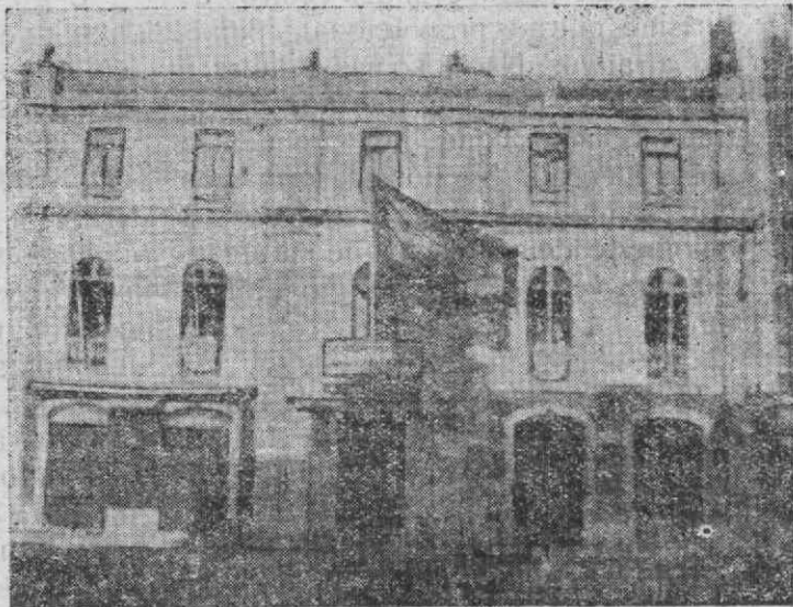
Edifício da Associação do Registo Civil
