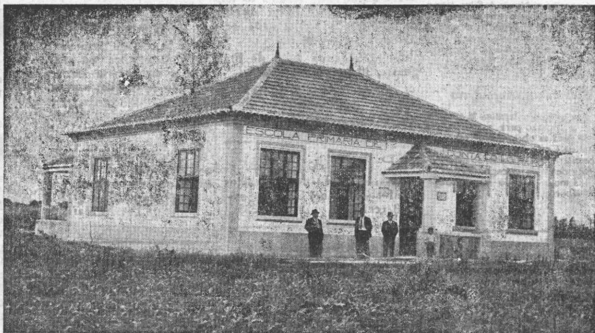
O maravilhoso edificio da Escola da Quintã do Loureiro, dotado de duas amplas salas e gabinetes, átrio, alpendrada e poço
